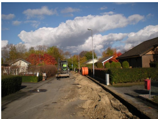
Enskiftesvägen under grävningsarbetet
